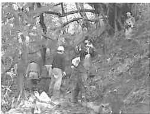
急斜面を切り開く作業開始
