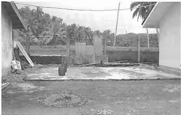
保健室建設予定地
