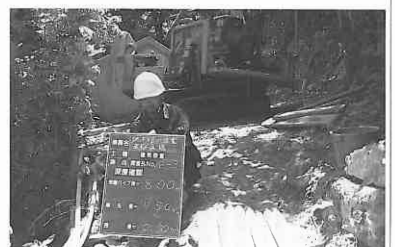
⑦ボーリング調査風景
