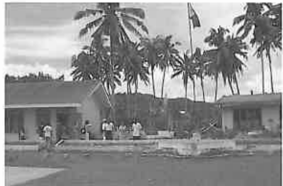
④台風で崩壊したままの調理実習室 左は当会が寄贈した教室
