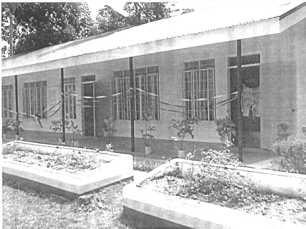
完成した教室 3棟
